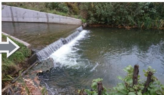
После (сброс в железобетонную канаву с отводом в водный объект)
