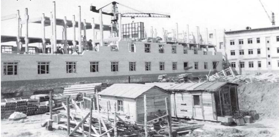
Строительство «горячей части» радиохимической лаборатории
